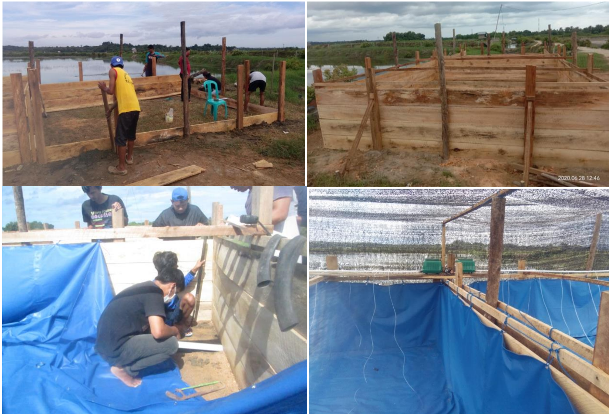
Gambar 2. Pembuatan rangka kolam, pemasangan kolam terpal dan instalasi aerasi.
