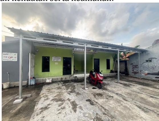
Gambar 2. Hasil Pembangunan Kanopi
