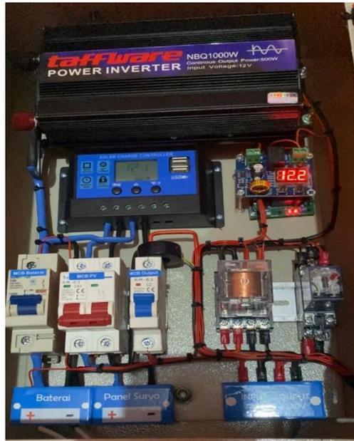
**Gambar 6. System instrumen kelistrikan PLTS Hybrid off-grid yang telah dirangkai di dalam box panel surya**
