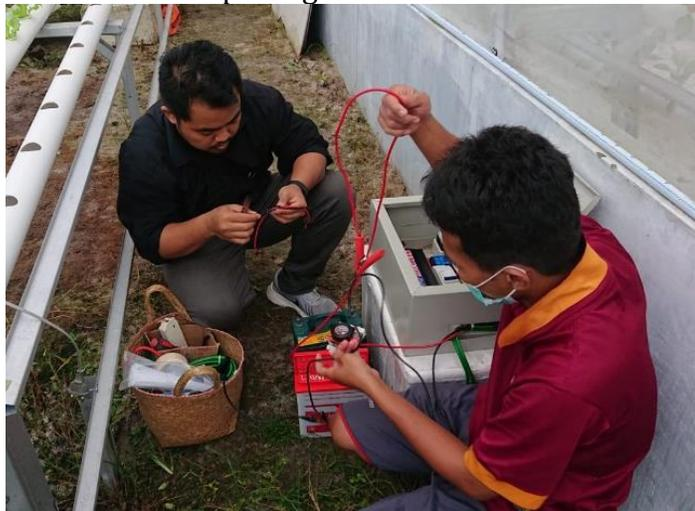
**Gambar 9. Proses instalasi Perangkat PLTS Hybrid Off-Grid pada UMKM terkait**
