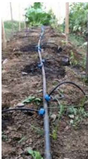
Gambar 5. Pemasangan Komponen Instalasi Drip System
