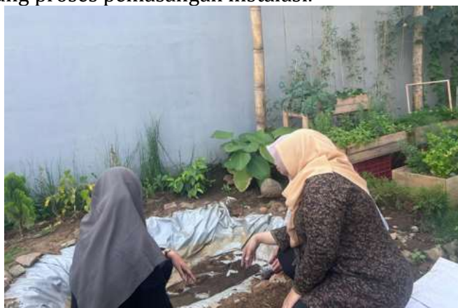
Gambar 3. Persiapan dan Pengecekan Lokasi Pemasangan Tandon dan Instalasi
