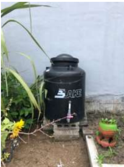
Gambar 4. Tandon Air yang Terpasang
