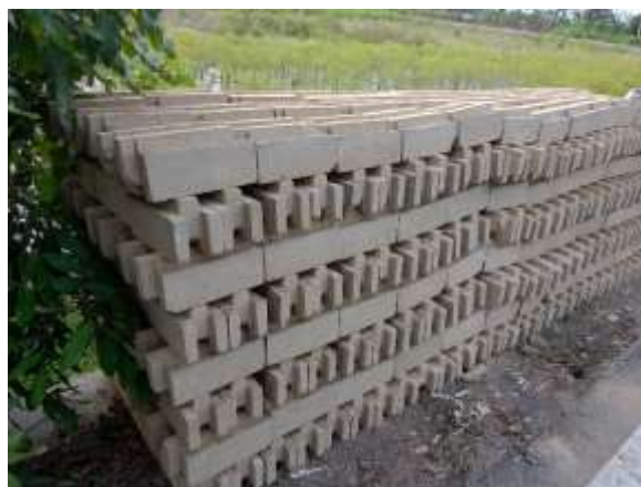
Gambar 9. Bata Tahan Api yang digunakan untuk pembuatan insinerator
