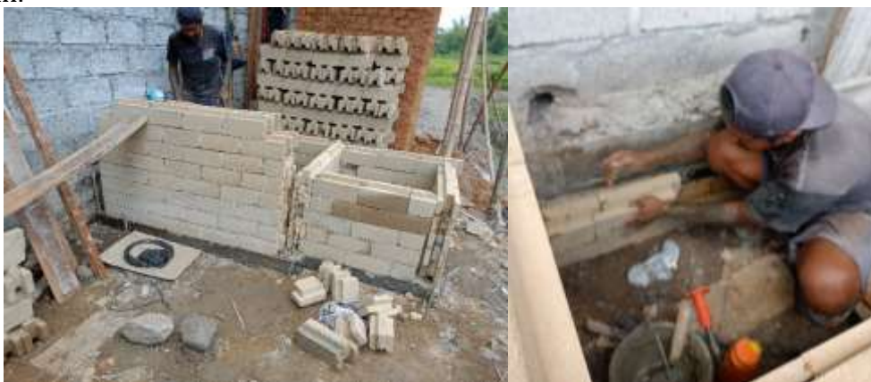
Gambar 10. Proses Pembuatan Insinerator
