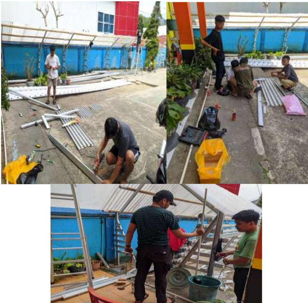
**Gambar 3: Perakitan instalasi hidroponik sistem DFT**
