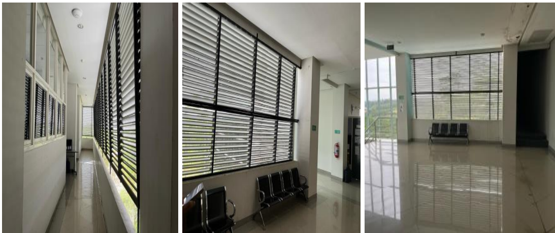
Gambar 6. Kondisi Existing Sun Shading Louvres Area Tunggu Lantai 3 Gedung (A) ITK
