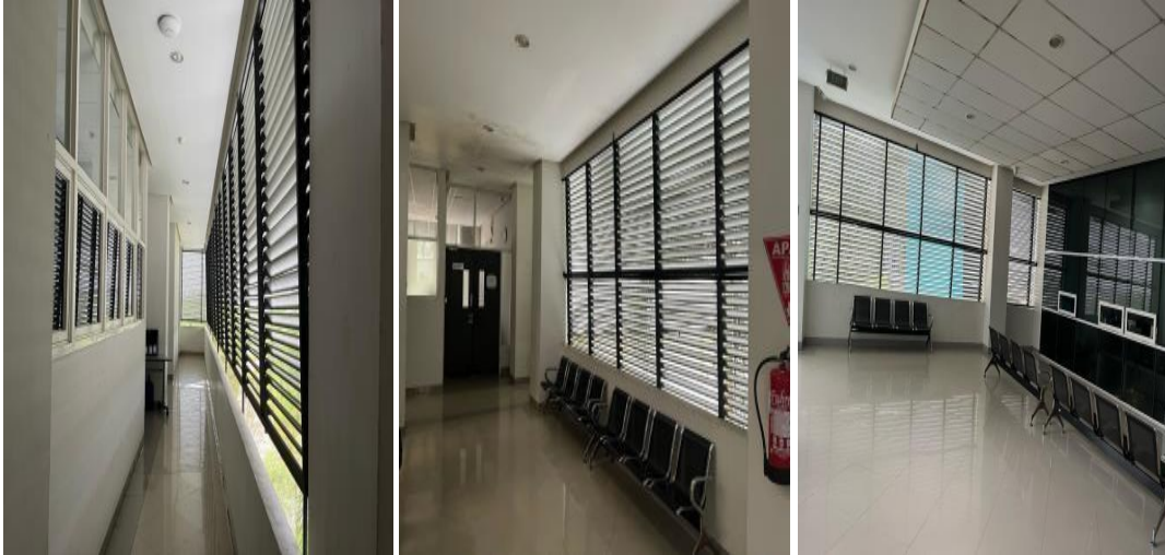
Gambar 5. Kondisi Existing Sun Shading Louvres Area Tunggu Lantai 2 Gedung (A) ITK
