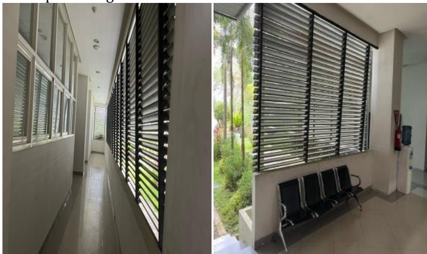
Gambar 4. Kondisi Existing Sun Shading Louvres Area Tunggu Lantai 1 Gedung (A) ITK
