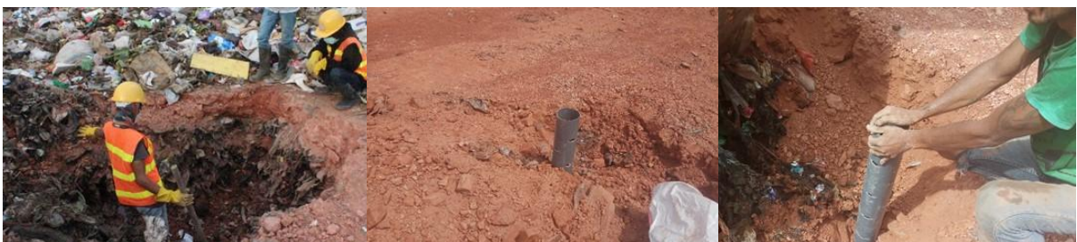
Gambar 12. Pantauan visual ketebalan timbunan dan instalasi pipa sirkulasi gas metana
