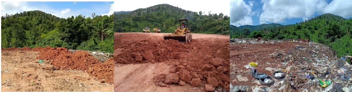
Gambar 10. Proses penghamparan tanah timbunan di atas permukaan timbunan sampah.
