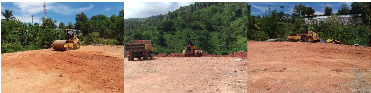
Gambar 11. Proses pemadatan tanah timbunan di atas permukaan timbunan sampah.
