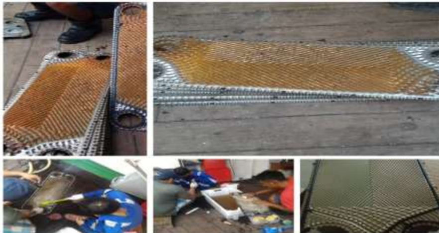
Gambar 2. Proses pembersihan plat – plat Heat exchanger KM. Madidihang 03
