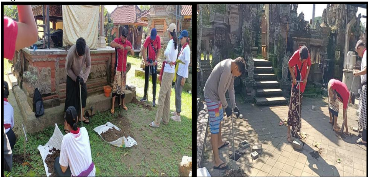
Gambar 3. Proses Pembuatan Biopori
