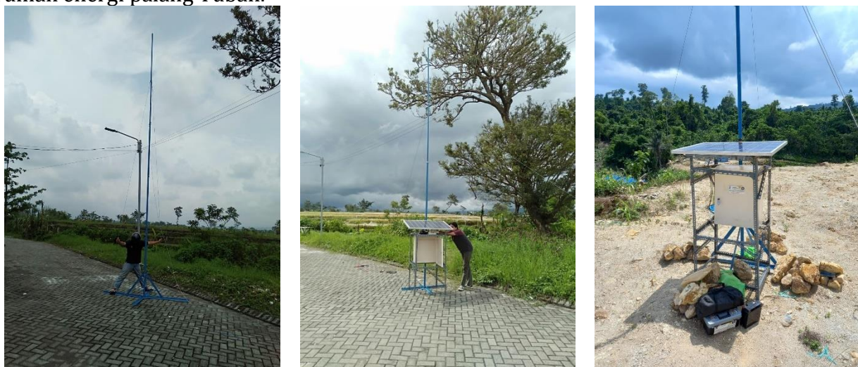
Gambar 4. Implementasi proteksi petir pada panel surya
